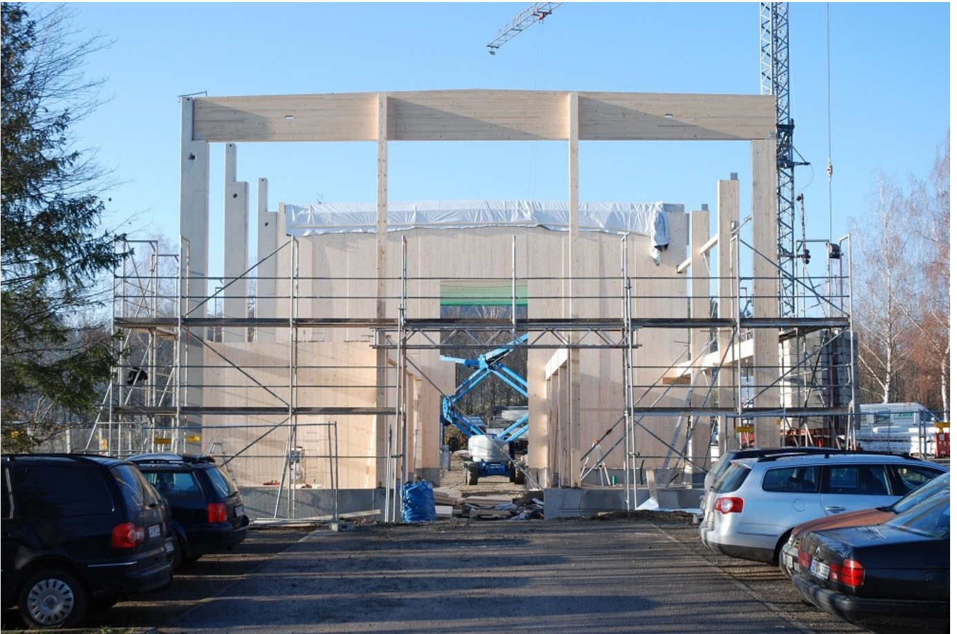
Neubau des Technikums der HFR. © Dederich, HFR
