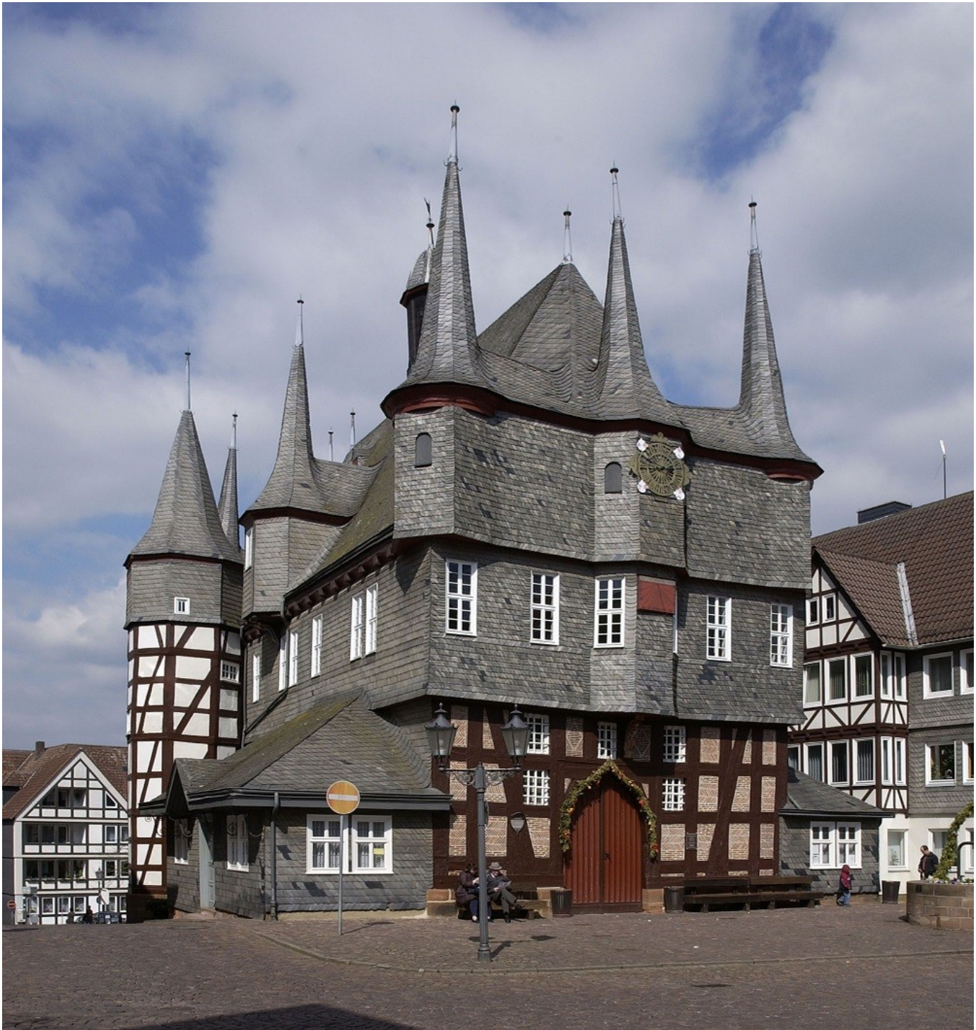
Rathaus Frankenberg an der Eder, errichtet 1509-1513. © INFORMATIONSDIENST HOLZ, Dederich
