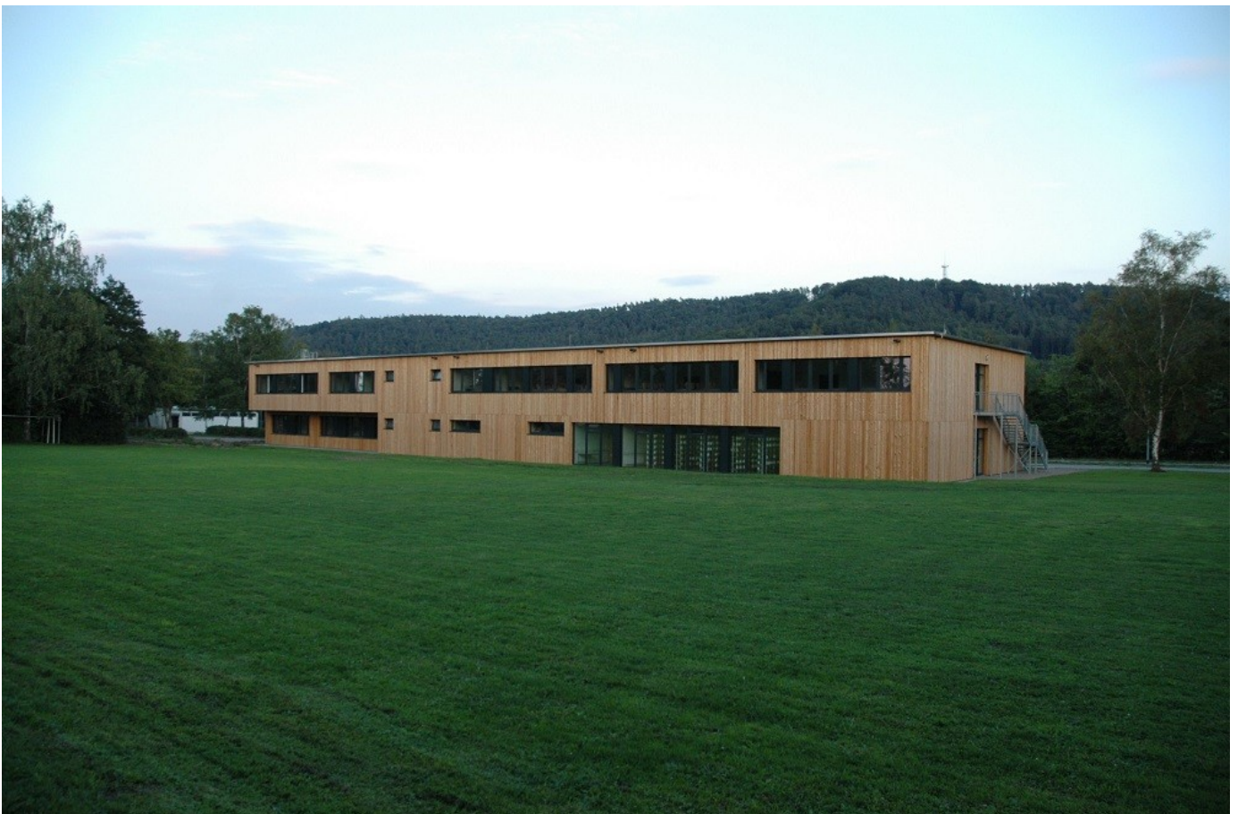
Laborgebäude auf dem Campus der Hochschule für Forstwirtschaft Rottenburg. © Dederich, HFR
