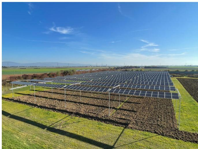
Bei hoch aufgeständerten Anlagen befinden sich die PV-Module in einer Höhe von mindestens 2,1 Metern über dem Boden. Sie ermöglicht eine landwirtschaftliche Nutzung unter den Solarmodulen, während in bodennahen Anlagen typischerweise die Flächen zwischen den Modulen bewirtschaftet werden.
