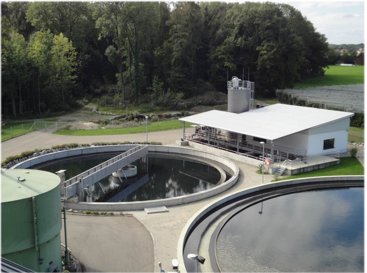
Adsorptionsstufe in der Kläranlage Kressbronn-Langenargen © KomS
