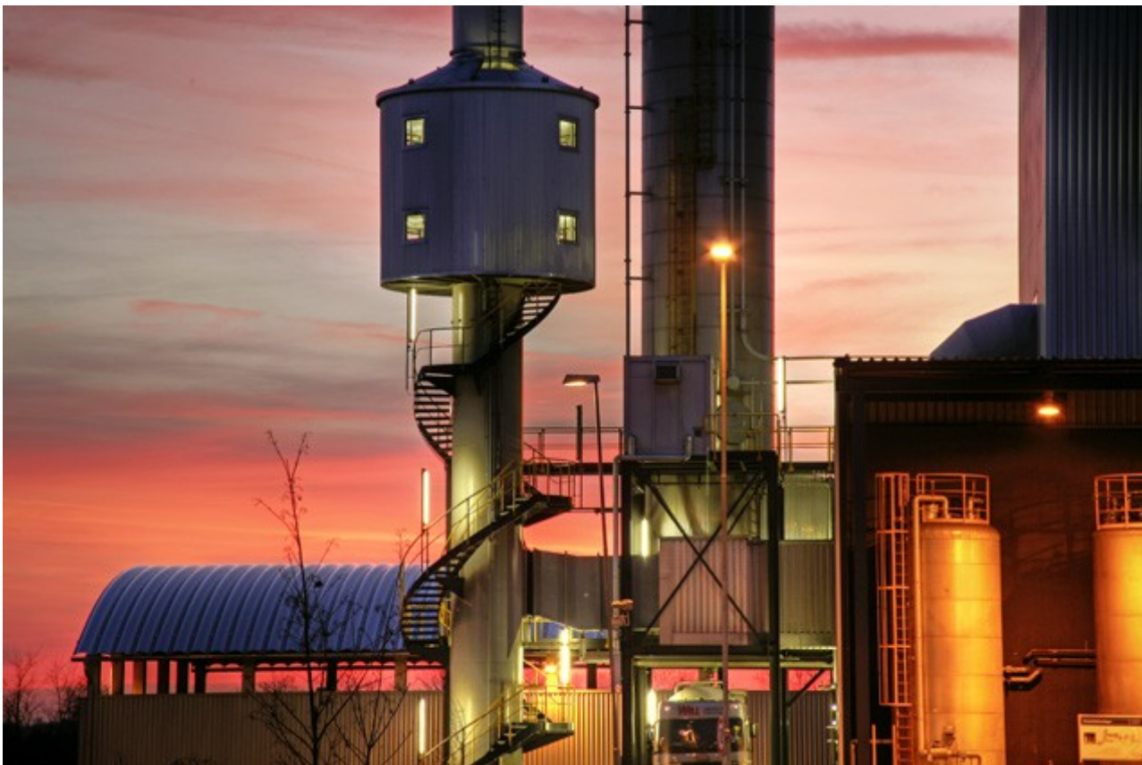
Die TREA Breisgau im Gewerbegebiet Breisgau ist ein Beispiel für eine Anlage, in der Müll zur Stromerzeugung verbrannt wird.
