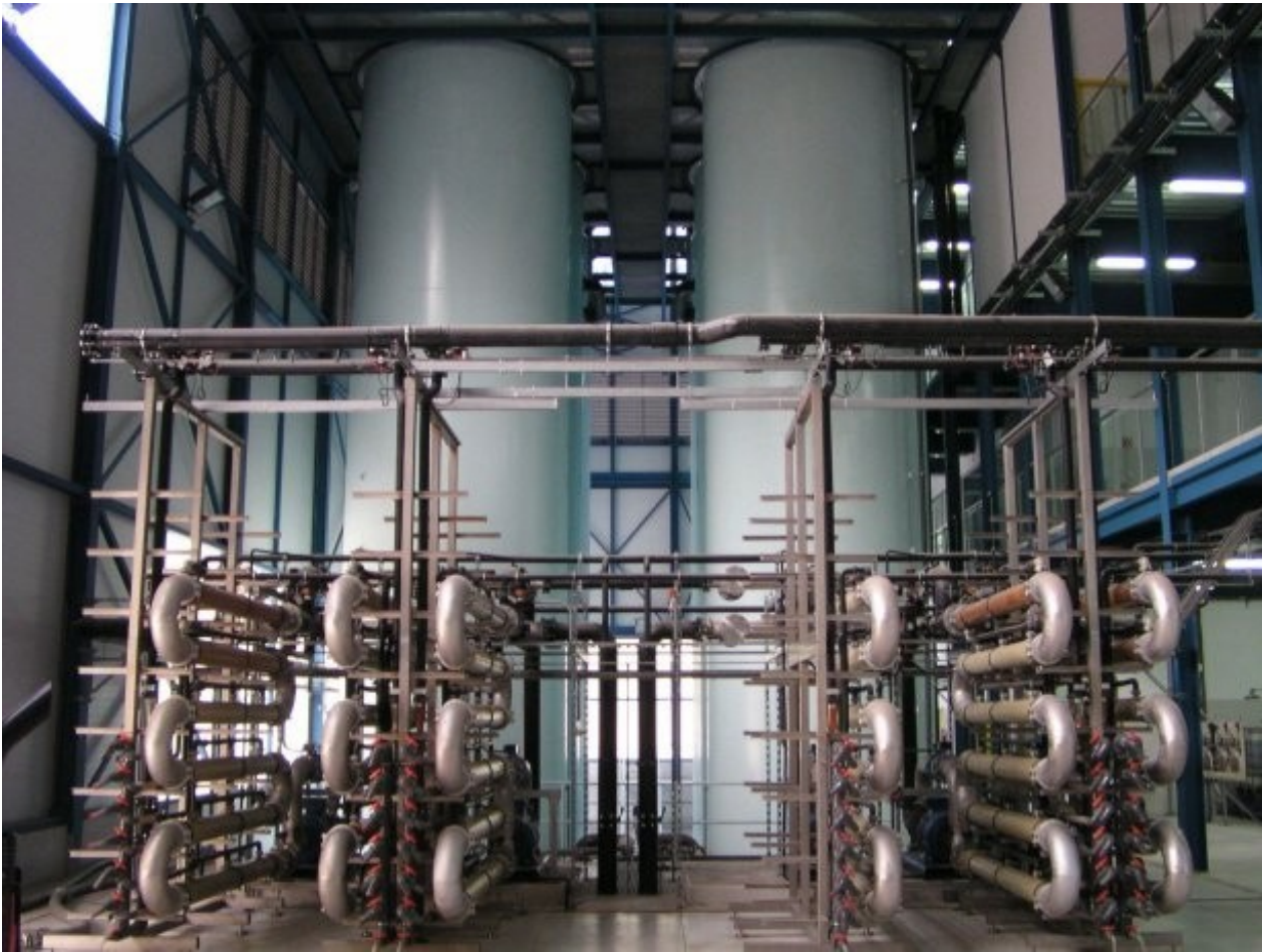
Abwasserreinigungsanlagen der Wehrle Umwelt GmbH arbeiten erfolgreich mit Biomembransystemen. © Wehrle Umwelt GmbH
