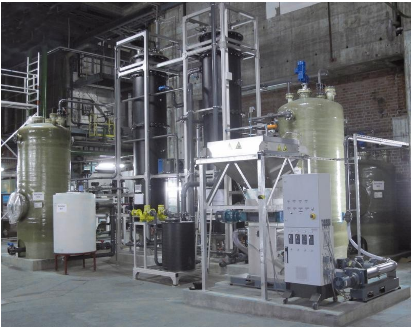
In dieser Stuttgarter Anlage wird aus Abfällen von Großmärkten Biogas hergestellt. © Fraunhofer IGB
